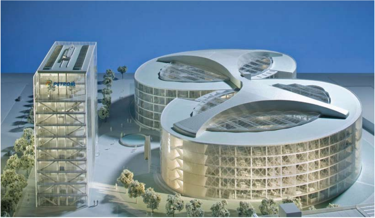
Petrom City Oval Ofis Binaları ve Üst Yönetim Binası
